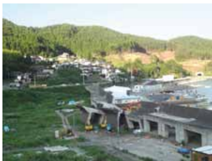
立派な防潮堤のあった地区ですが、低地の住宅は全て破壊されました。低地には公園ができる予定です。
