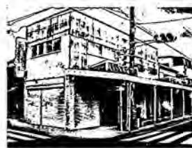
写真1 既存空店舗外観
