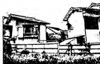
写真4 駐車場より N邸(左)と増改築予定地に建つ 住宅(右)
