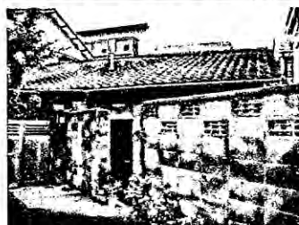
写真3 隣家との接続部分 屋根の途中から隣家である
